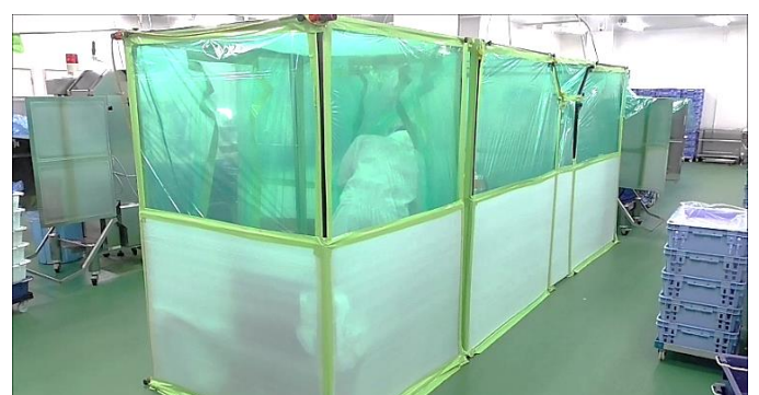
隔離養生枠組み (食品工場)
