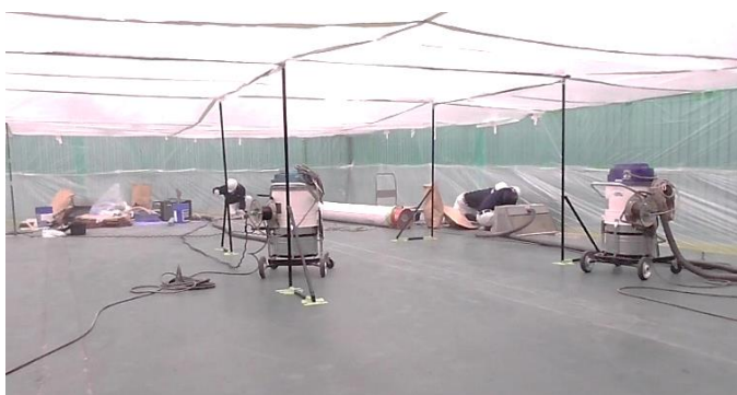
隔離養生枠組み (食品冷蔵庫)
