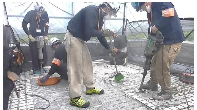
タイル撤去作業
