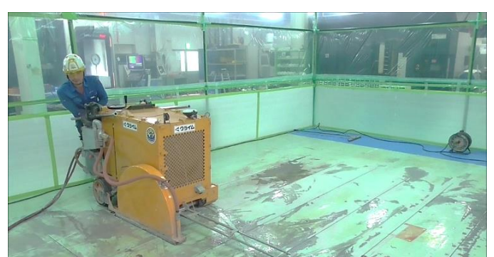
隔離養生枠組み (精密機械工場)
